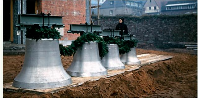
Das Hochhieven der Glocken war nur mit Hilfe eines Flasenzuges möglich, die größte Glocke wiegt 700 kg, die kleinste 250 kg.
